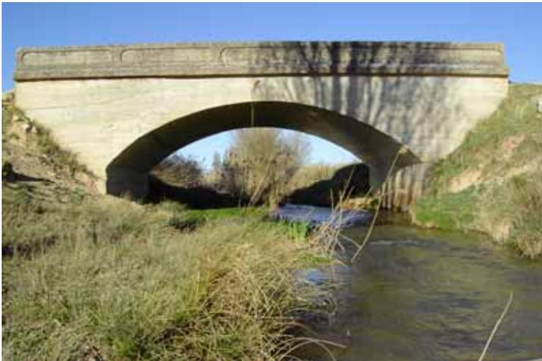
Se excavaron 77,962 m<sup>3</sup> en emplazamiento; 78,504 m<sup>3</sup> en cimientos; 78,504 m<sup>3</sup> de hormigón; 78,436 en estribillos.
