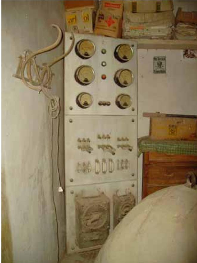
*Tablero de instrumentos del generador de electricidad*
